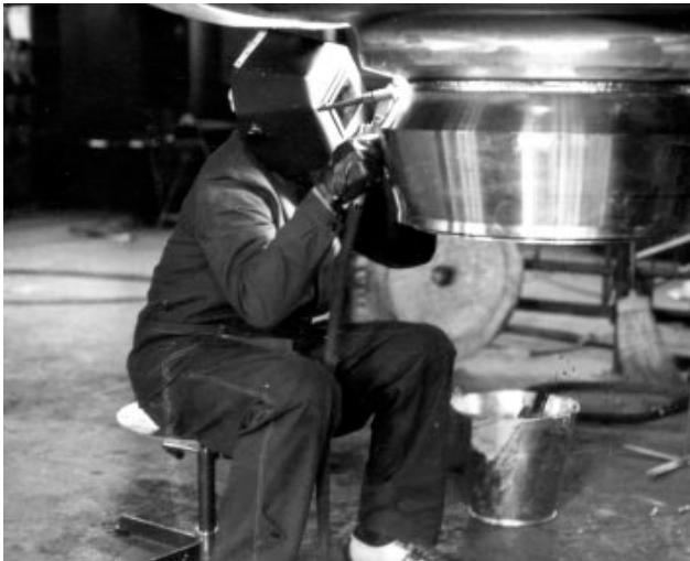
A Škoda művek szakembere Pakson hegeszti fel a végleges beemelés előtt álló reaktor kivezetőcsonkjait
