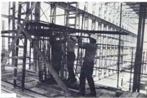
A turbinaszatellit vaszerkezetének szerelése
