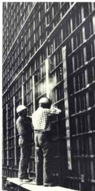
Lengyel hegesztők a reaktorblokk cellafelépésénél
