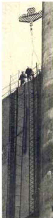
Lengyel munkások a kettős kiépítésen
